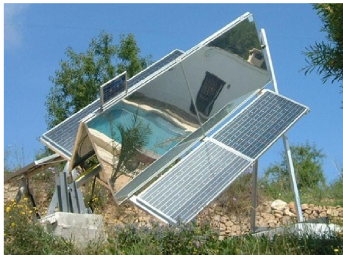
Obr. 4.11 Pohyblivý solární panel instalovaný ve Španělsku (500W) [28]
