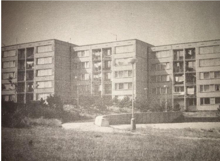
Obrázek 28: Pohled na sídliště v blízkosti Chvalského zámku (Antes, Balák 1988).
