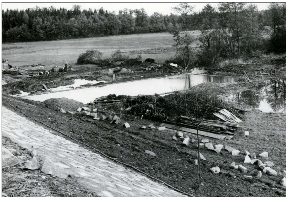
Obrázek 62 Pohled na obnovu rybníka Chobot na Vinicích. Hráz se upevňovala žulovými kameny, zdroj: Muzeum Vysoké Mýto, foto: Bohumil Skarlický (1961)
