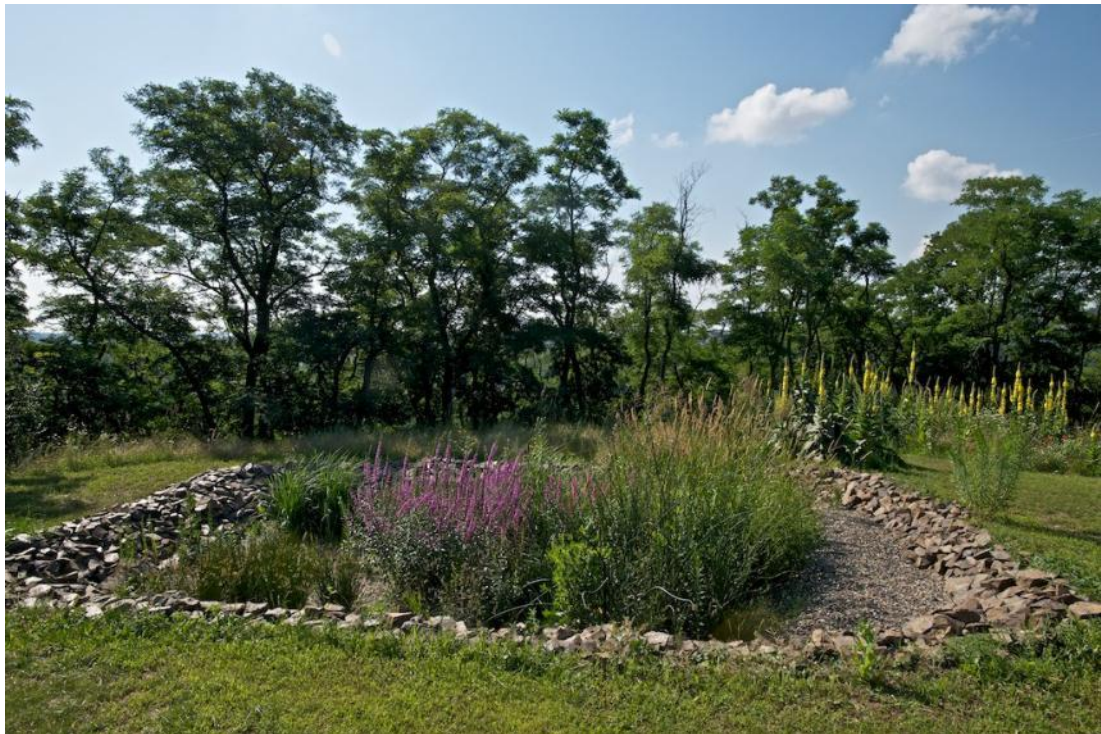
Obrázek 3 , kořenová čistírna Řež u Prahy ( www.korenova-cisticka.cz ).
