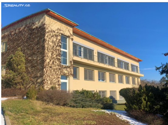
Obrázek 6-4 Administrativní budova, (zdroj: [11], zpracování vlastní)
