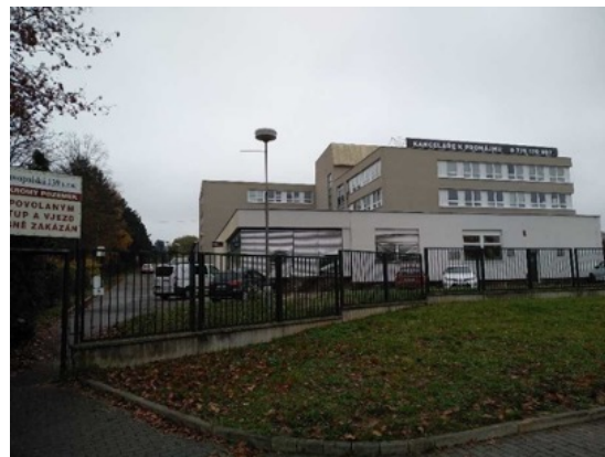
Obrázek 6-3 Pohled na budovu A, (zdroj a zpracování vlastní)
