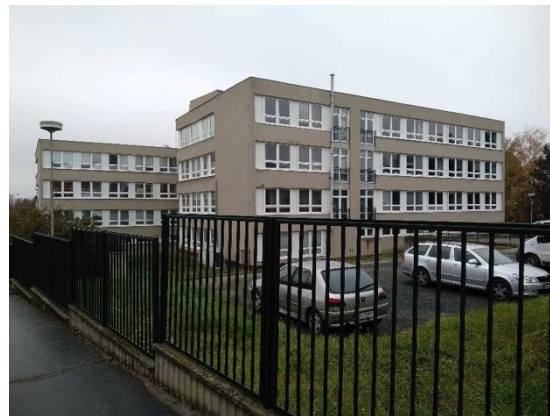
Obrázek 7-3 Pohled na budovu B&C, (zdroj a zpracování vlastní)
