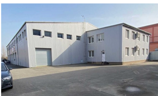
Obrázek 8-6 Skladovací budova (zdroj: [24], zpracování vlastní)
