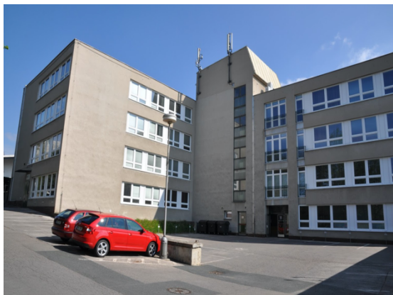
Obrázek 7-2 Pohled na budovu B&C, (zdroj a zpracování vlastní)
