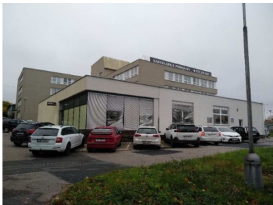
Obrázek 6-2 Pohled na budovu A, (zdroj a zpracování vlastní)
