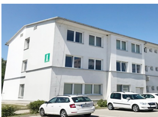
Obrázek 6-5 Administrativní budova, (zdroj: [12], zpracování vlastní)
