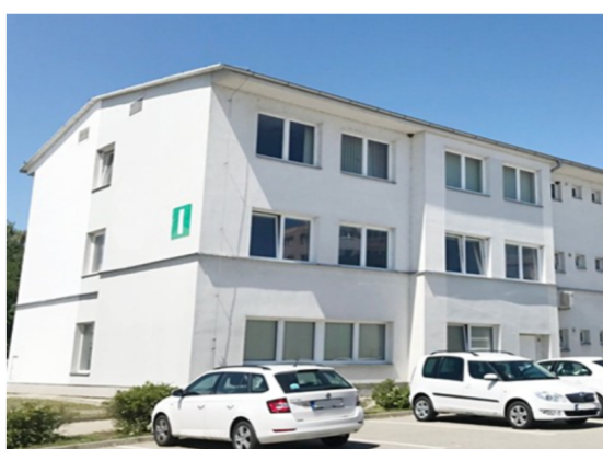
Obrázek 6-5 Administrativní budova, (zdroj: [12], zpracování vlastní)
