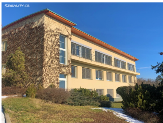
Obrázek 6-4 Administrativní budova, (zdroj: [11], zpracování vlastní)
