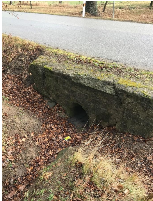
Pohled na vtok
