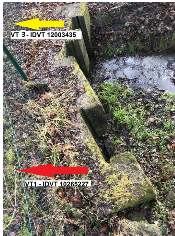
Obrázek 6: Rozdělovací objekt v obci
