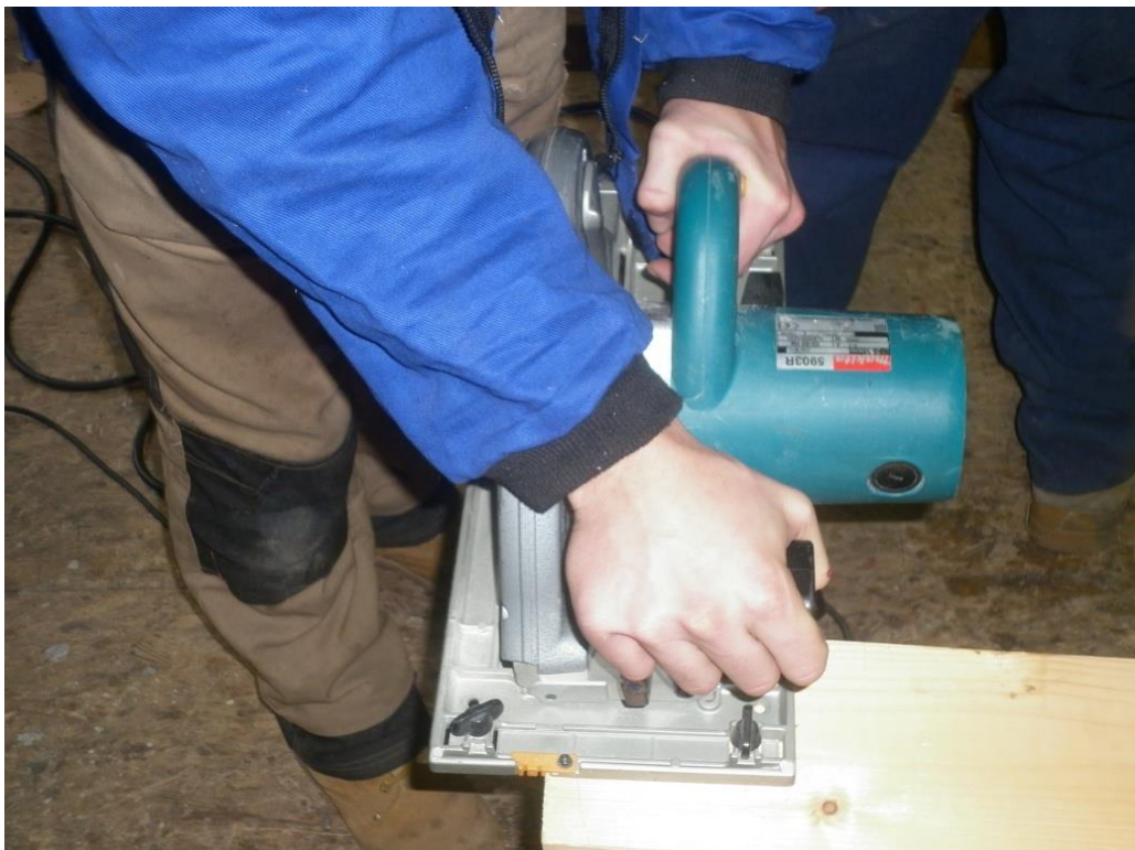
Obr 26: Držení ruční elektrické kotoučové pily levákem (vlastní tvorba)
