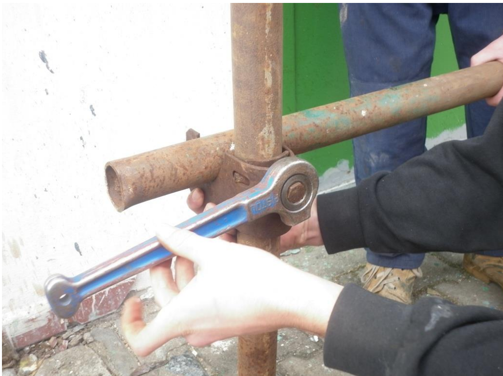
Obr 40: Montáž trubkového lešení – uchycení lešeňové sponky levákem (vlastní tvorba)
