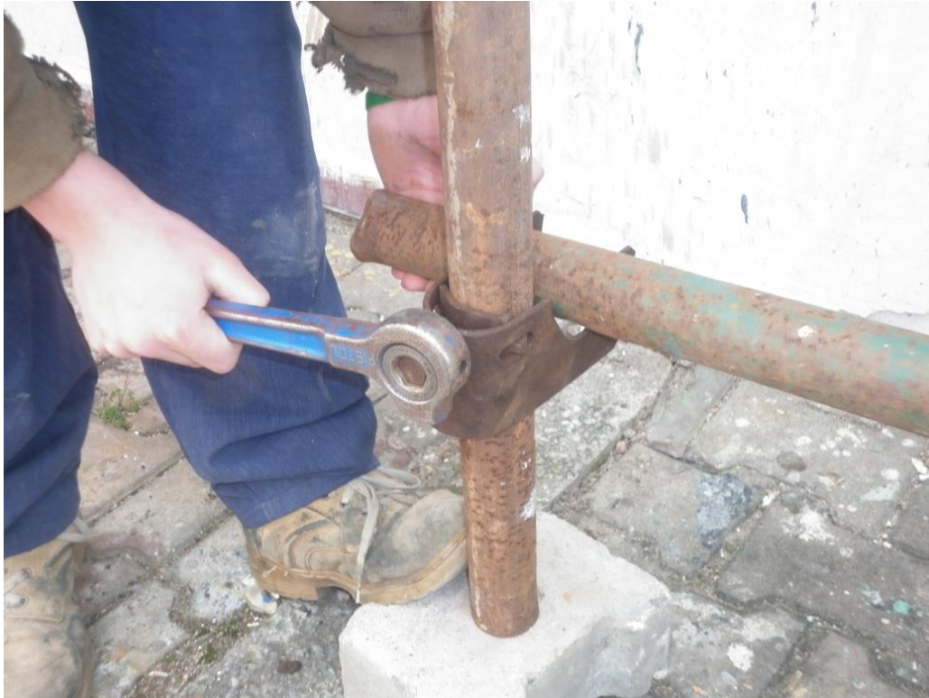
Obr 39: Montáž trubkového lešení – uchycení lešeňové sponky pravákem (vlastní tvorba)
