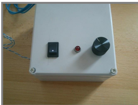
Obr. 18 Ovládání elektrického vyhřívání
