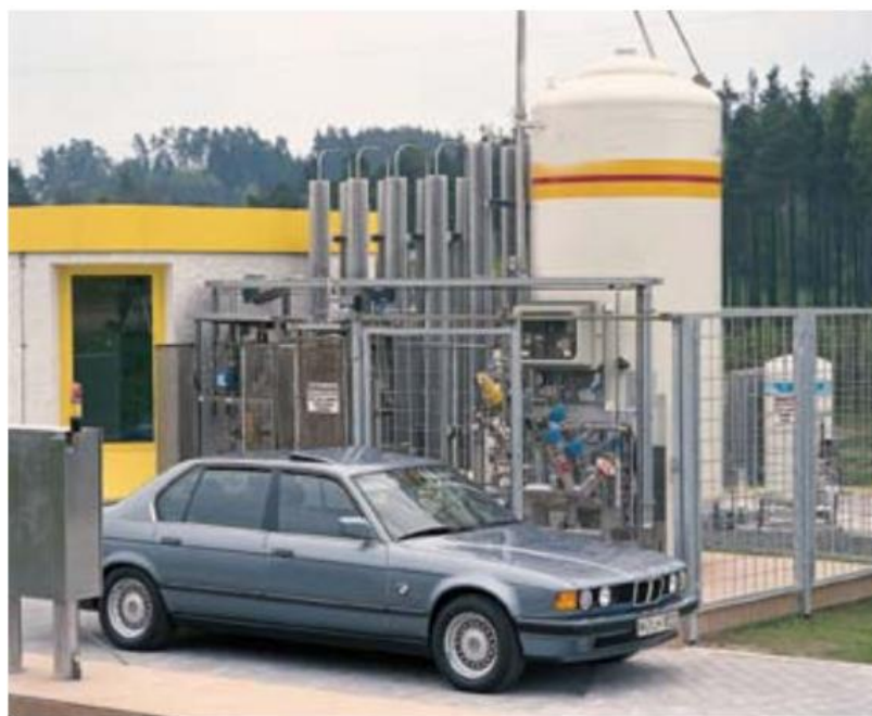
Obr. 27 Čerpací stanice vodíku pro pohon vozidel [9]
