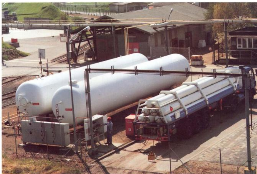
Obr. 25 Bateriový vůz a velkokapacitní tlakový zásobník [9]
