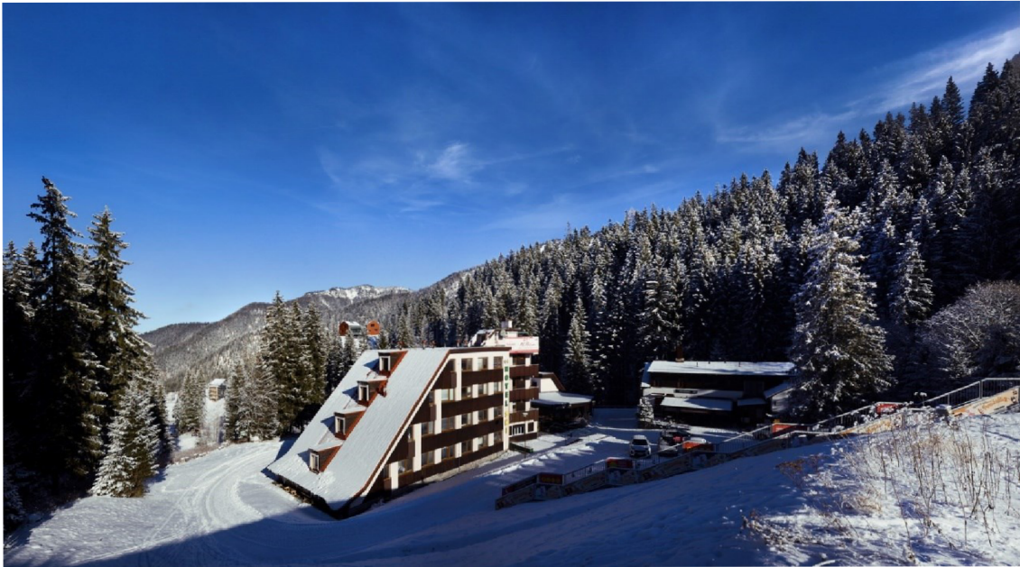
Obr. 3.1 Exteriér hotelu SKI
