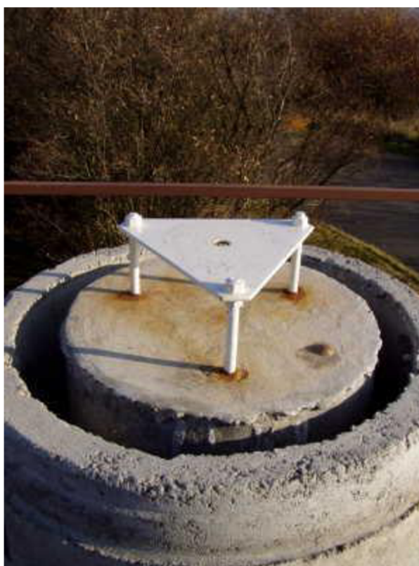
Obrázek 2.8 Nucená centrace na jednom z pilířů vnitřní základny [26]
