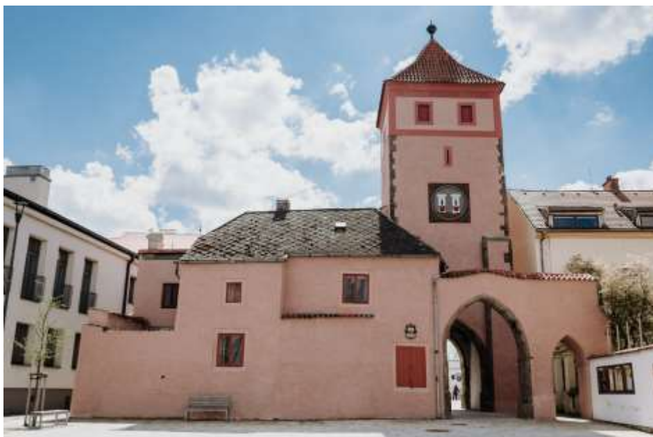
Obr. 4/ Pražská (Červená) brána v Horažďovicích. [Zdroj: Stavba roku Plzeňského kraje, dostupné z: https://www.stavbarokupk.cz/dt_stavby/prazska-cervena-brana-v-horazdovicich/ , vyhledáno: 1. 5. 2024]
