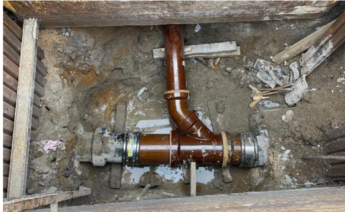
Obrázek 1 - Realizace kameninové odbočky na stávající kanalizační řad (Vlastní)
