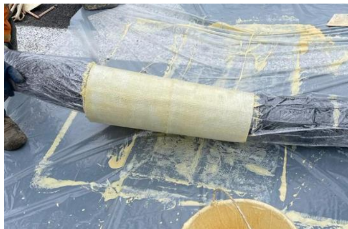
Obrázek 18 - Navlečení krátké vložky na packer (Vlastní)
