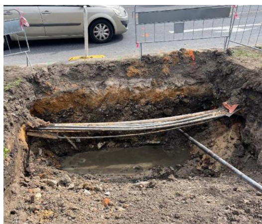
Obrázek 7 - Foto z realizace metodou HDD – startovací jáma (Vlastní)
