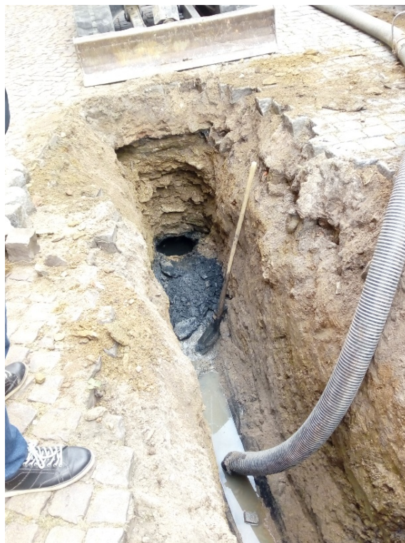
Příloha 7 – Čištění místa pro usazení nového potrubí. (vlastní tvorba)
