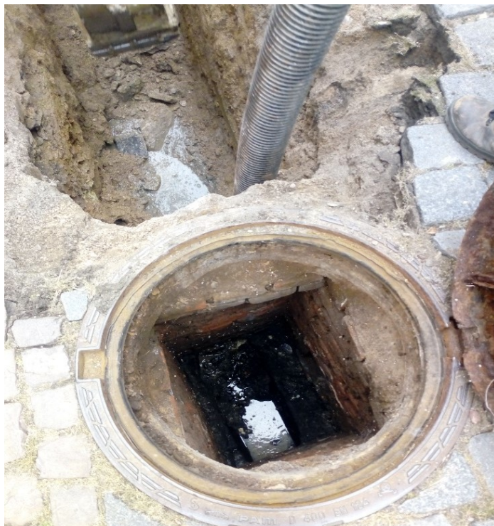
Příloha 5 – Zanesená kanalizace splašky. (vlastní tvorba)
