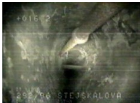
Obrázek 11: Zborcení stoky (Šejnoha, 2003) Obrázek 12: Narušení stoky cizím tělesem (Šejnoha, 2003)
