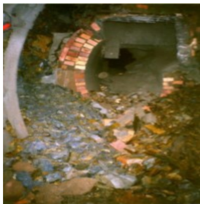
Obrázek 11: Zborcení stoky (Šejnoha, 2003) Obrázek 12: Narušení stoky cizím tělesem (Šejnoha, 2003)
