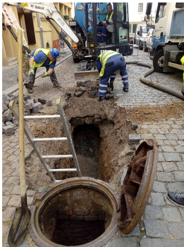
Příloha 6 - Ruční výkopové práce. (vlastní tvorba)
