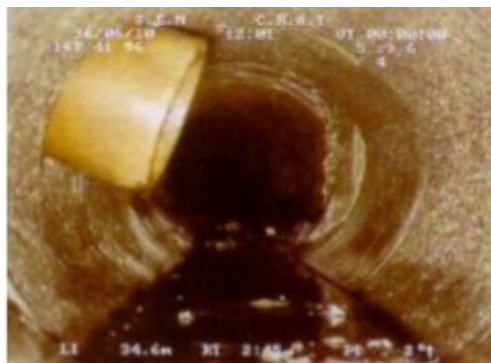
Obrázek 8: Chybné napojení přípojky (Šejnoha, 2003)
