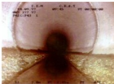
Obrázek 9: Obroušená spodní část stoky (Šejnoha, 2003)
