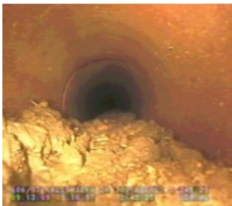
Obrázek 10: Zanášení stoky (Šejnoha, 2003)
