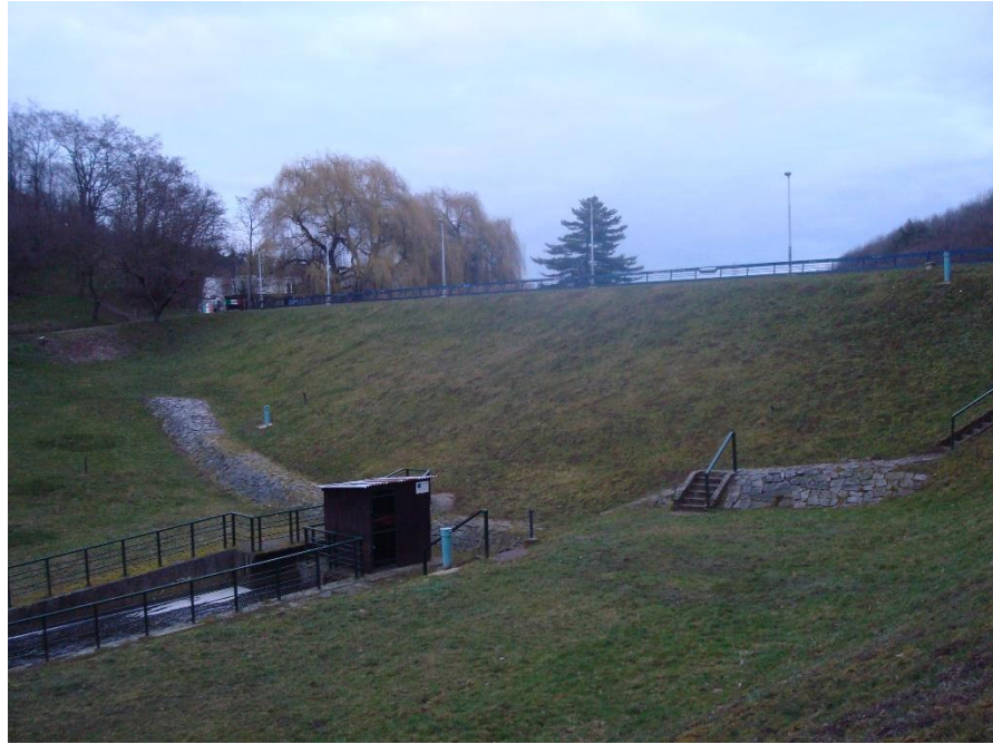
Obr.10. Pohled na vzdušný svah hrázového tělesa. Vlevo ovládání výpusti. (zdroj: fotografie autora)
