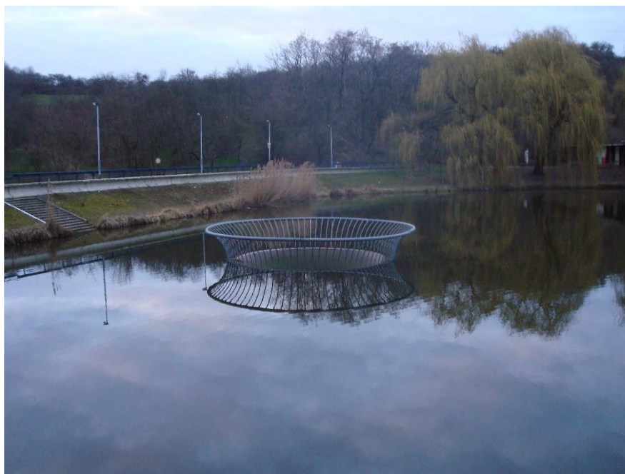
Obr. 11. Šachtový bezpečnostní přeliv nádrže Džbán. (zdroj: fotografie autora)
