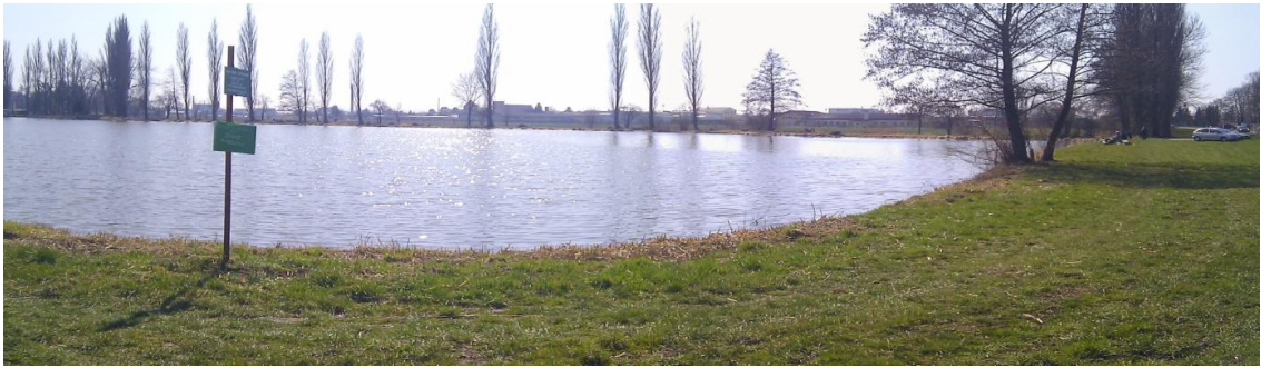
Obr. č. 15: Soustava Retenční nádrže, 2013
