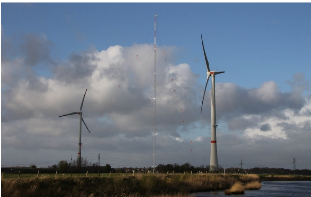
Obr. 31 Větrné elektrárny Multibrid M5000 [122]
