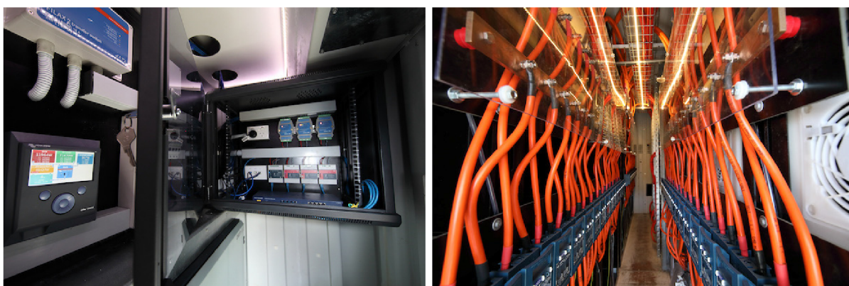
Obr. 13 Interiér kontejnerového úložiště LSB [67, 69, 70]
