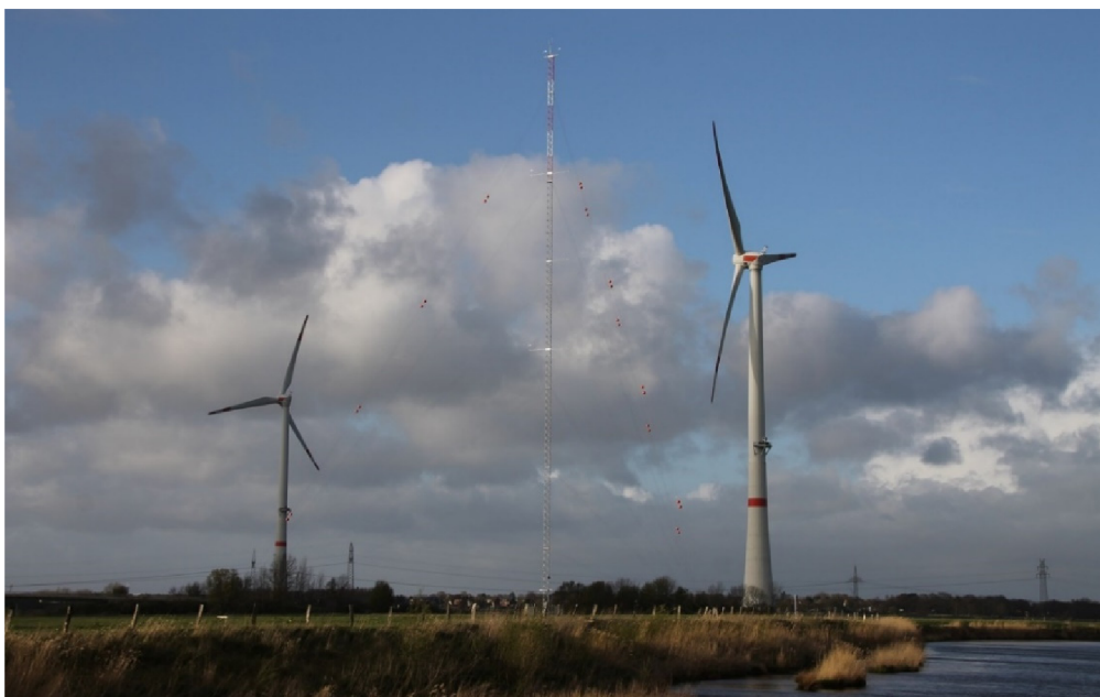
Obr. 31 Větrné elektrárny Multibrid M5000 [122]
