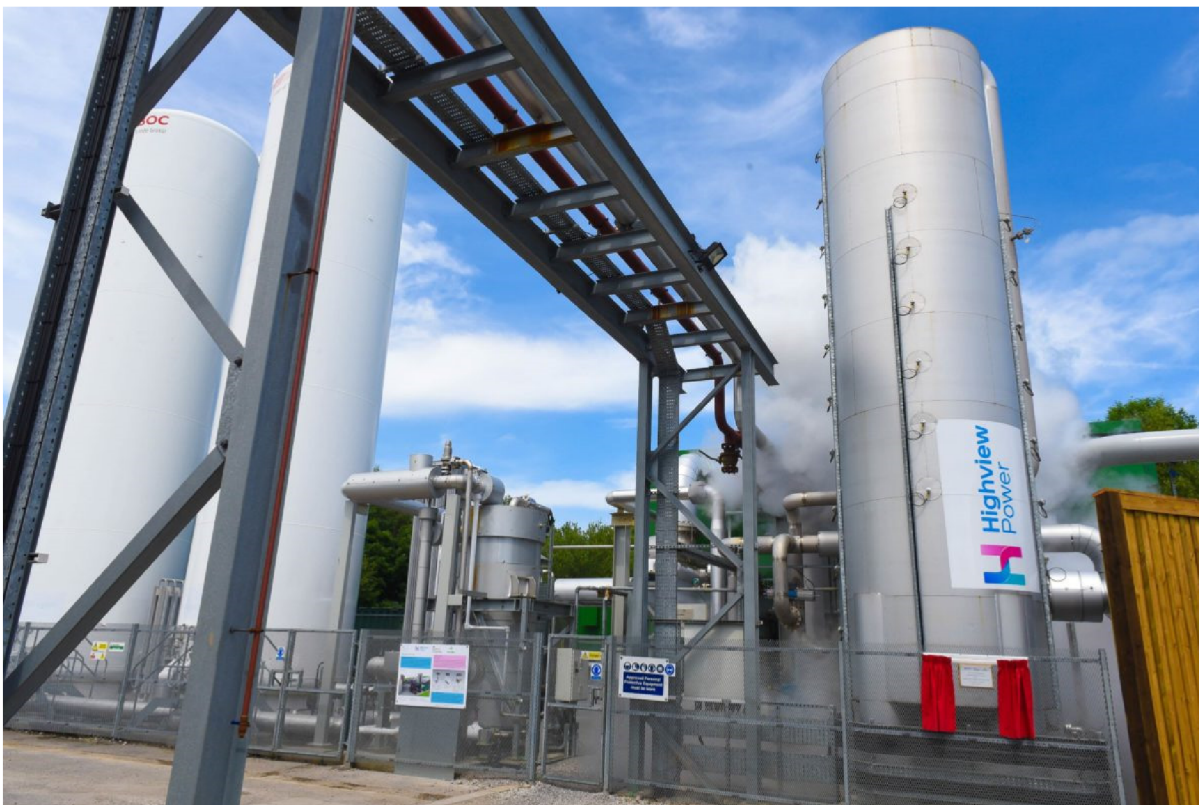
Obr. 29 5MW úložiště energie od Highview Power instalované u Manchesteru [121]
