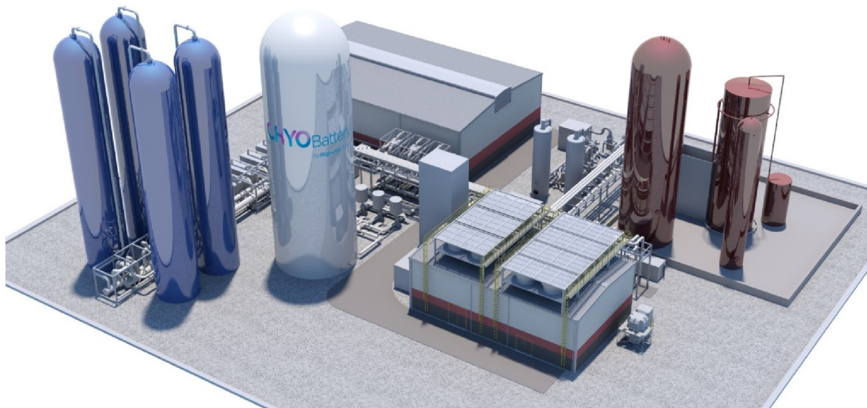
Obr. 26 Akumulační elektrárna CRYOBattery od Highview Power [115]
