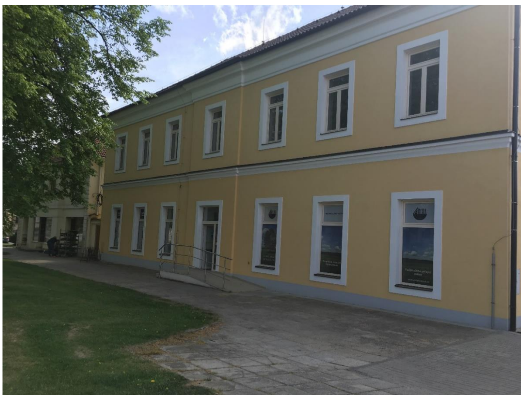
Obrázek č. 3 b: Budova bývalé školy prošla řadou rekonstrukcí. Kvůli značně vzrostlé vegetaci před budovou bohužel nebylo možné budovu zachytit ve stejném úhlu jako na původní fotografii. V prostorách se nyní nachází centrum České spořitelny (Michalová, 2018).
