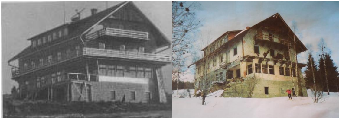
Obr. 3: Pešlova chata r. 1938 (Reichardtovi, J. a B., 2005-2011) a obr. 4: Pešlova chata z roku 1991 (Bučina-Buchwald, 2015)
