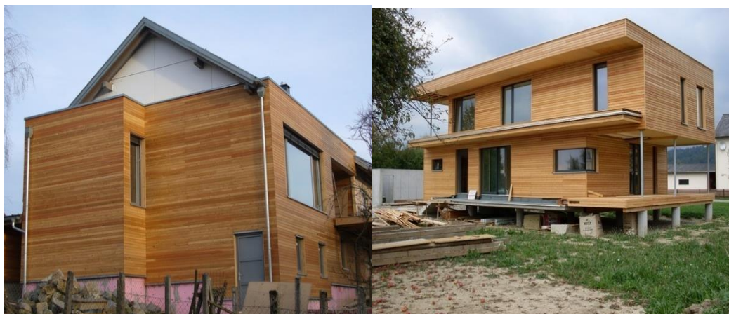
Obr. 11. Fasáda z profilů Rhombus z modřínu sibiřského http://www.palubky-seca.cz/stranky/poradna/navody/drevene-fasady---rady-a-tipy.htm
