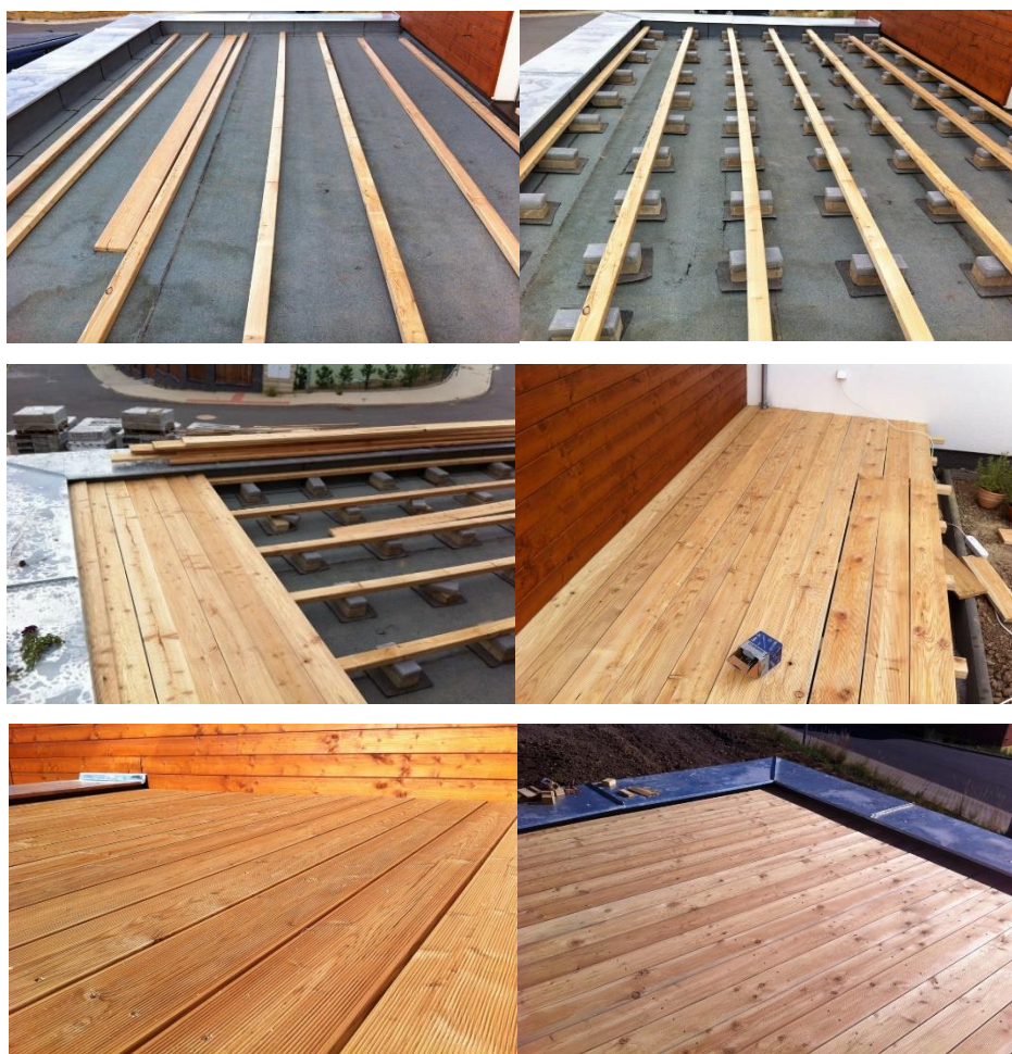
Obr. 9. Postup montáže a pokládky terasových prken z modřínu sibiřského https://stavoblog.cz/terasa-ze-sibirskeho-modrinu-navod/
