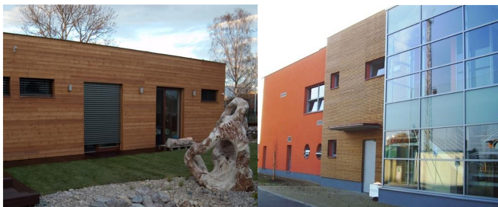
Obr. 7. Fasáda z borovicových palubek http://www.dum-zahrada.net/thermowood/venkovni-obkladove-profilu/
