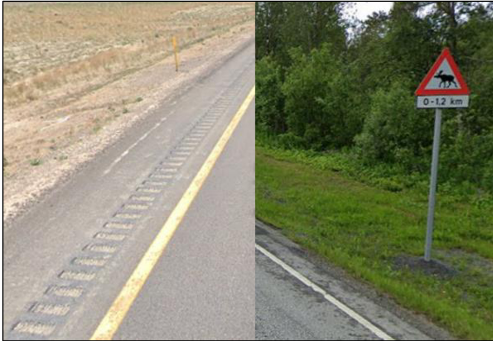
Obr. č. 4 – Vlevo drážky v silnici USA, vpravo dopravní značení Skandinávie, zdroj: archiv autora
