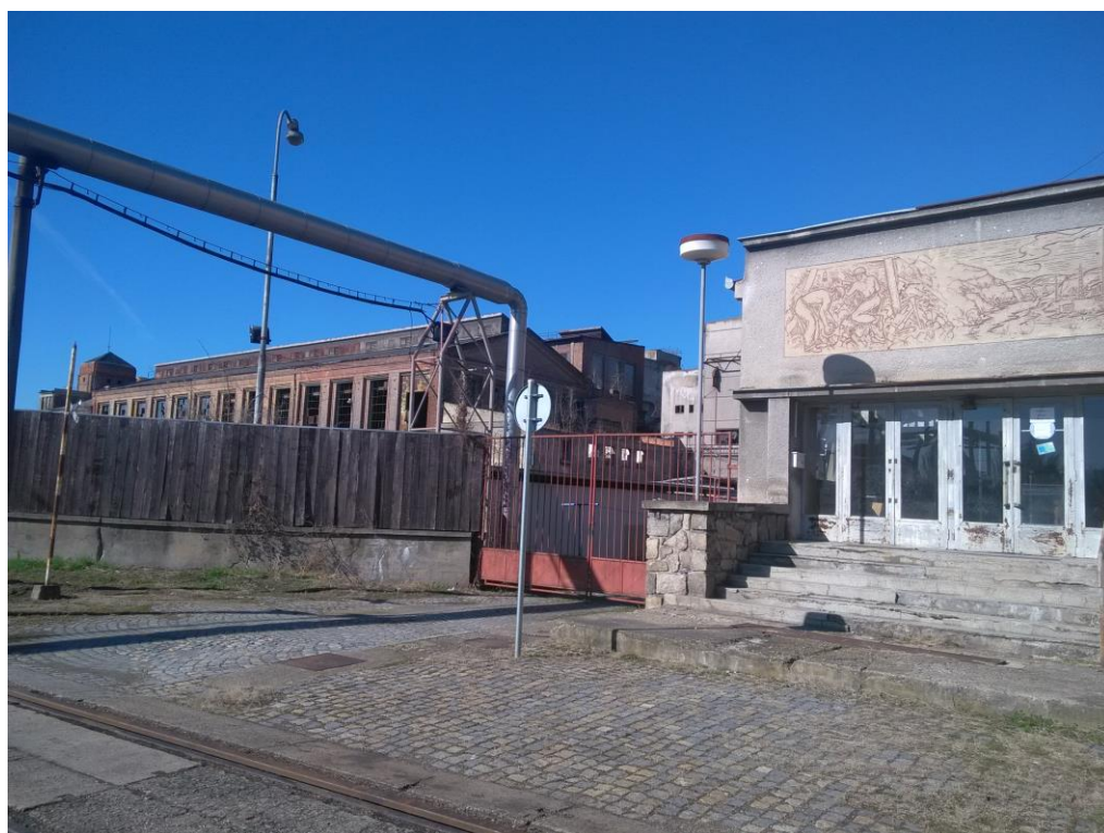
Příloha č. 27: Polorozpadlé torzo bývalé elektrárny v Oslavanech (foto: P. Skálová, 2017).
