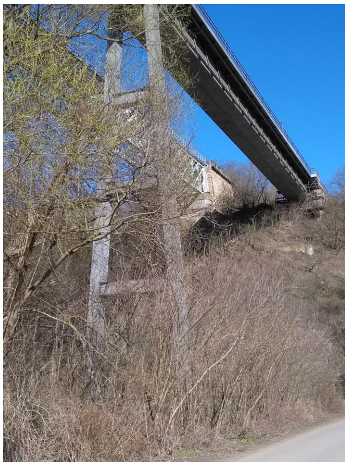
Příloha č. 19: Starý a nový železniční viadukt (foto: P. Skálová, 2017).
