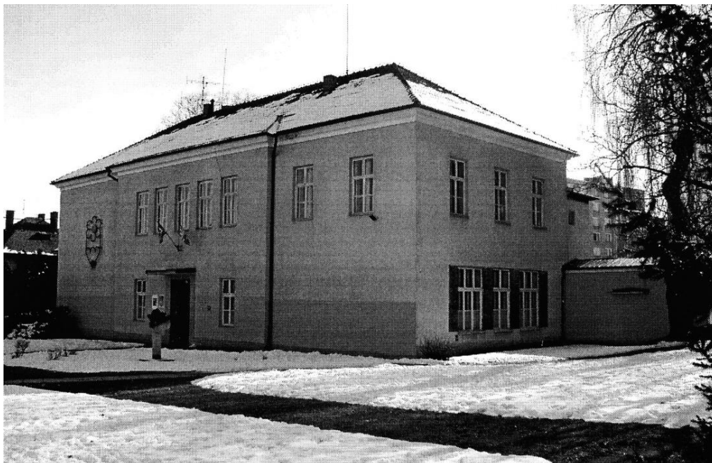
Dnešní podoba budovy Korunního prince Rudolfa na ulici I.P.Pavlova (dnes zde sídlí Základní umělecká škola)
