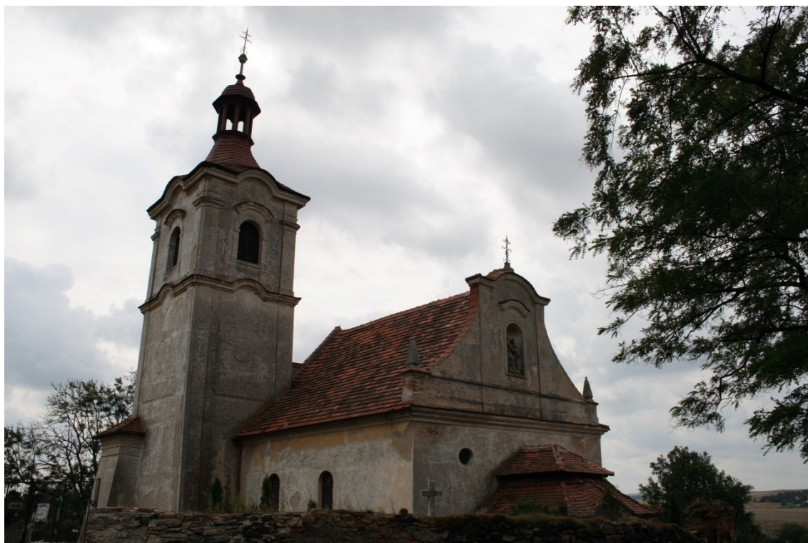
Obrázek 91 Polní Voděradý, kostel Navštívení Panny Marie, pohled od severozápadu
