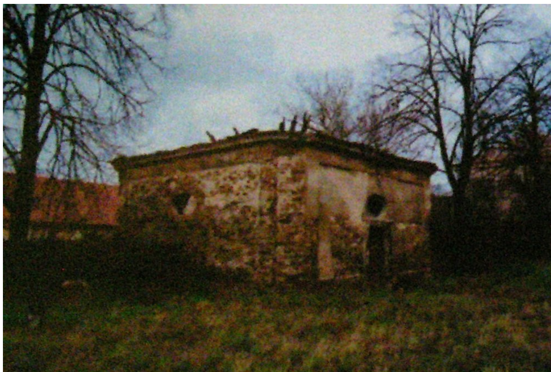
Obrázek 101 Starý Kolín, márnice na severní straně kostela
