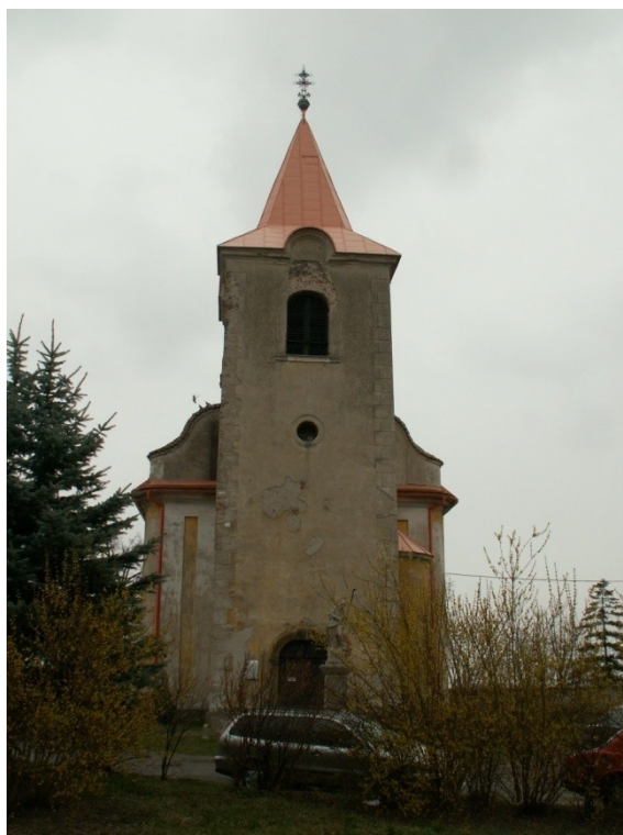
Obrázek 115 Týnec nad Labem, kostel sv. Jana Křtitele, průčelí
