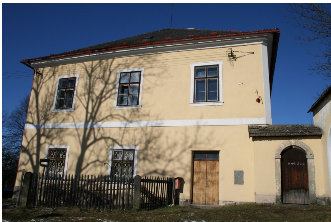
Obrázek 30 Brandýs nad Orlicí, fara
