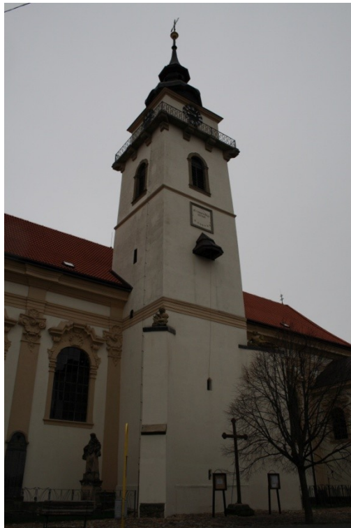
Obrázek 44 Heřmanův Městec, kostel sv. Bartoloměje, věž na jihu
