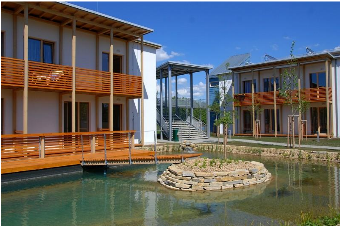
Obr. 11: Stínění pomocí samonosné konstrukce (Brno-Modřice, dům pro seniory) (Web 13).
