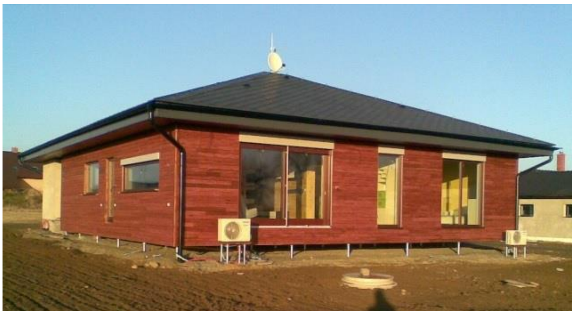
Obr. 6: Založení dřevostavby na zemních vrutech od firmy Krinner (Web 10).
