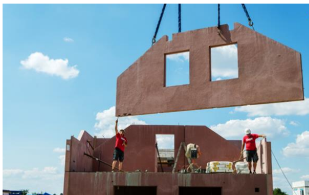
Obrázek 28 Stávající prefabrikovaná výstavba stěnových prvků [47]
