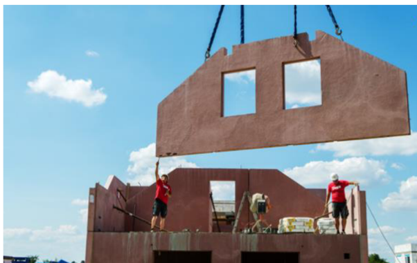
Obrázek 28 Stávající prefabrikovaná výstavba stěnových prvků [47]
