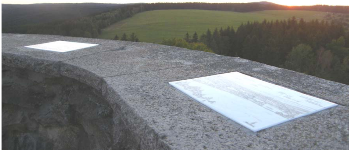
obr. 162 Horní ochoz rozhledny s porcelánovými deskami směrniců.
