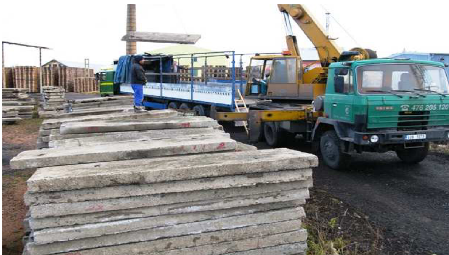
Obr. 3.4 Stavba staveništní komunikace
