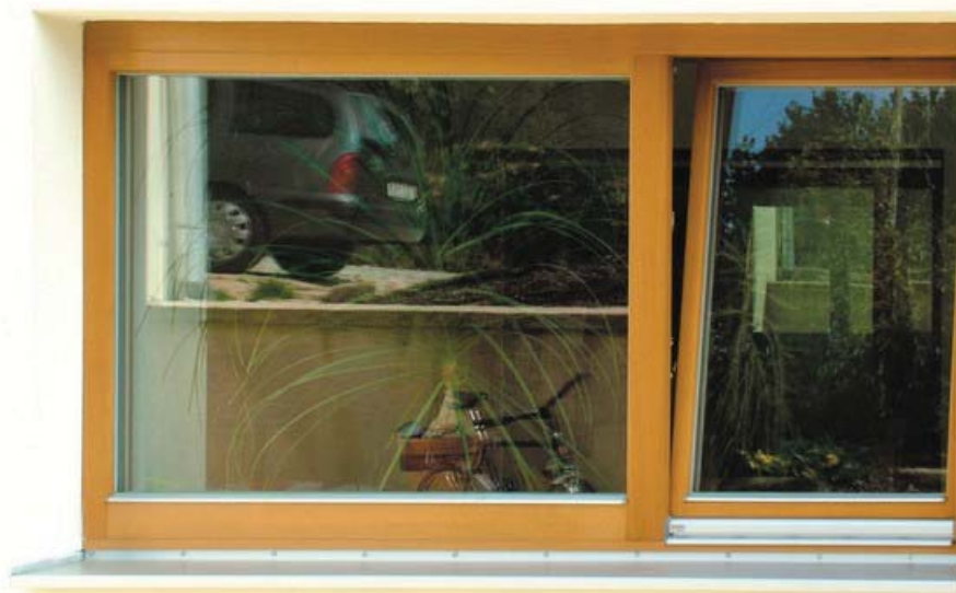
obr. 6.7 Okno s otevíravou a neotevíravou částí a s vyrovnáním skel na stejnou výšku [77]
