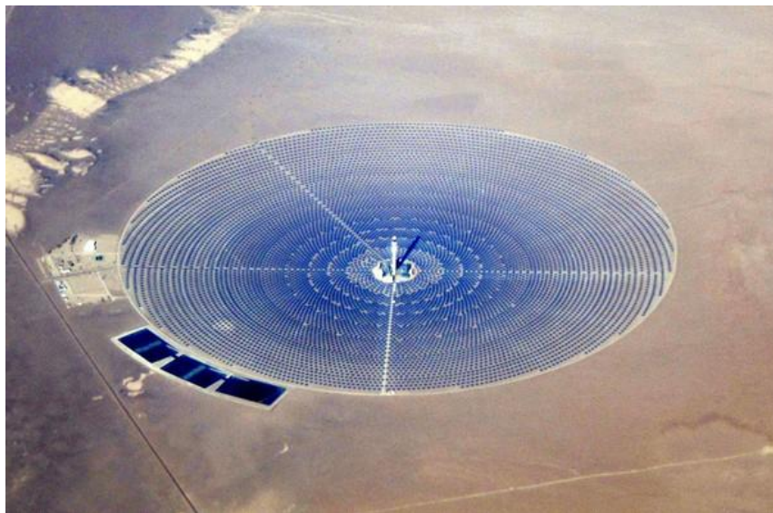
Obr. 5.8: Solární elektrárna – heliostaty s věží uprostřed [24].
