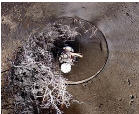
Obr. 5.2 Prorostlé kořeny do kanalizace [27]
