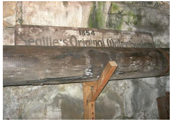
Obr. 4.2 Dřevěné potrubí – kulatina [23]
