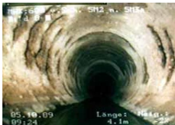
Obr. 5.5 Síranová koroze [27]
