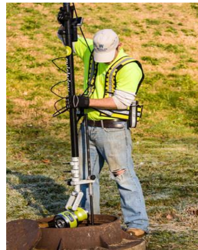
Obr. 7.7 Průzkum pomocí šachtové kamery [47]
