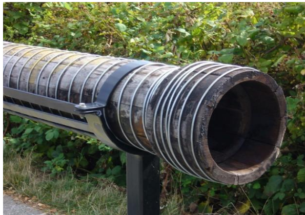
Obr. 4.1 Dřevěné potrubí – tyčový styl [23]
