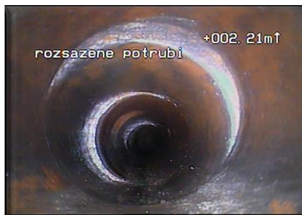
Obr. 5.3 Vychýlené potrubí [27]
