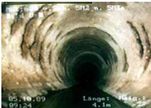
Obr. 5.5 Síranová koroze [27]
