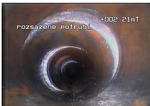
Obr. 5.3 Vychýlené potrubí [27]
