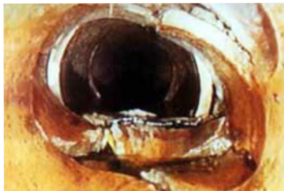
Obr. 5.7 Zborcení potrubí [22]
