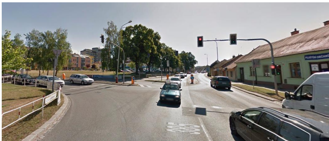
Obrázek 12: Pohled na světelně řízenou křižovatku II/385 II/386 v Kuřimi ve směru z Tišnova
