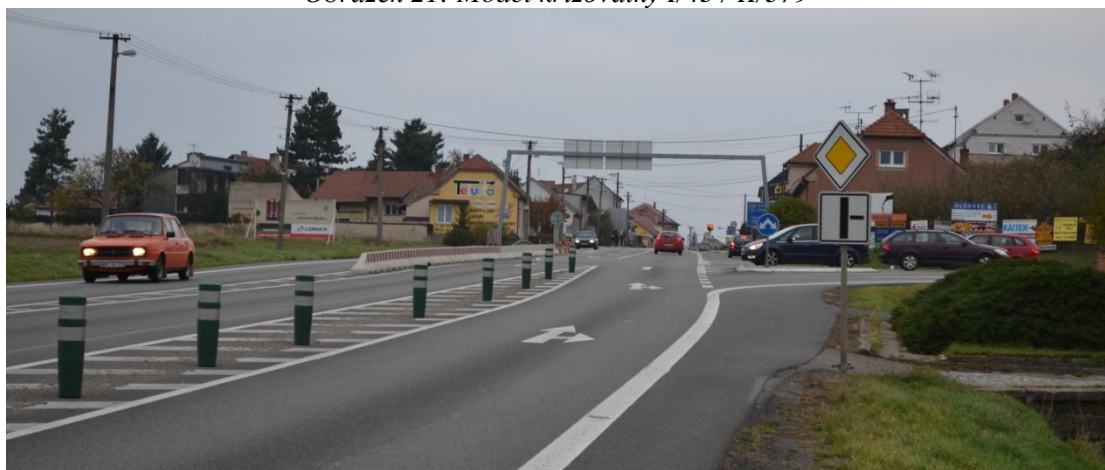
Obrázek 22: Křižovatka I/43 / II/379 v Lipůvce ve směru z Brna
