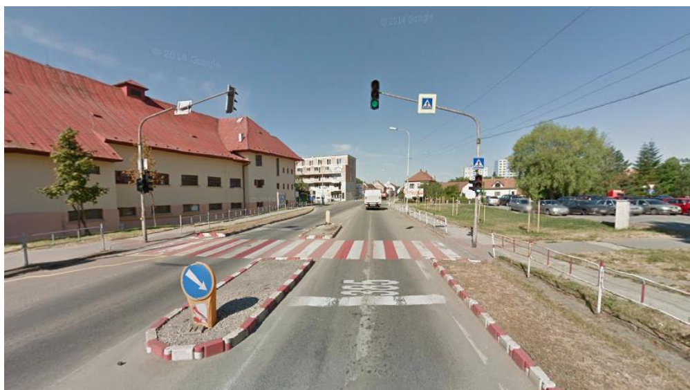
Obrázek 14: Pohled na světelný přechod pro chodce v obci Kuřim
