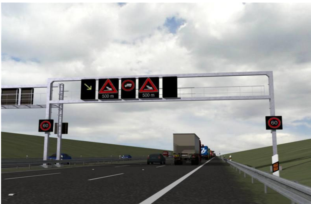
Obrázek 25: Portál pro liniové řízení dopravy
