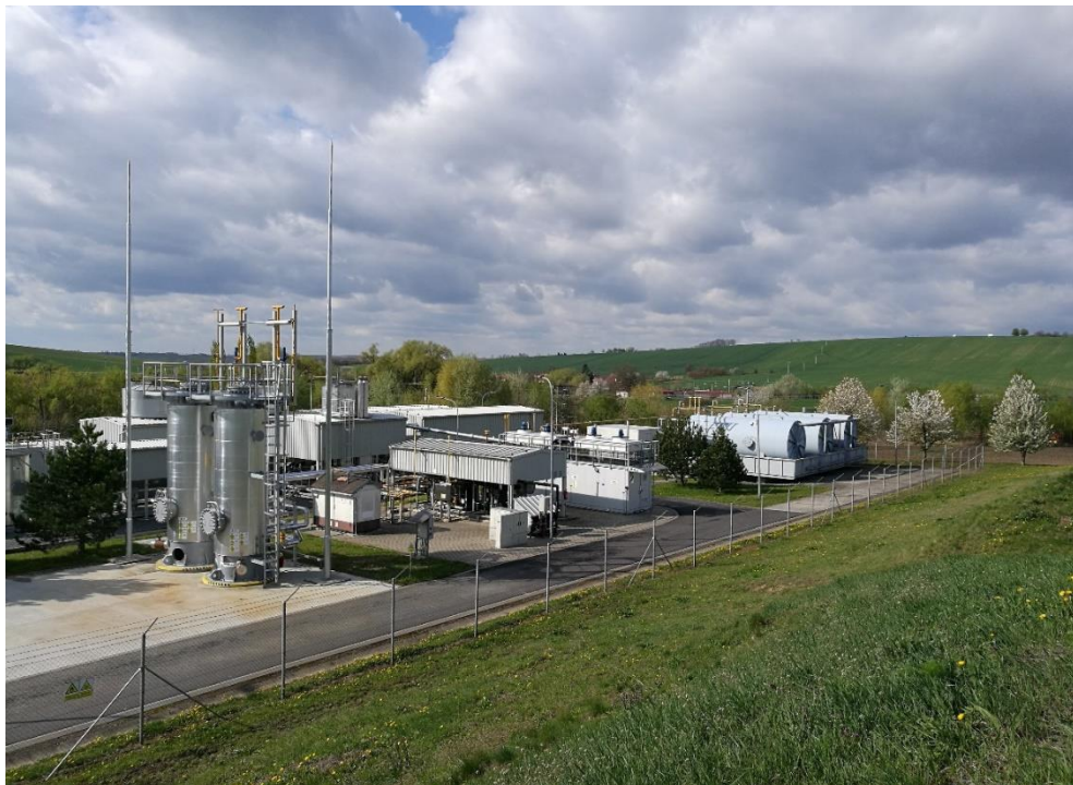
Obrázek 15: Středisko na úpravu ropy v obci Žarošice, zdroj: fotografie autorky
