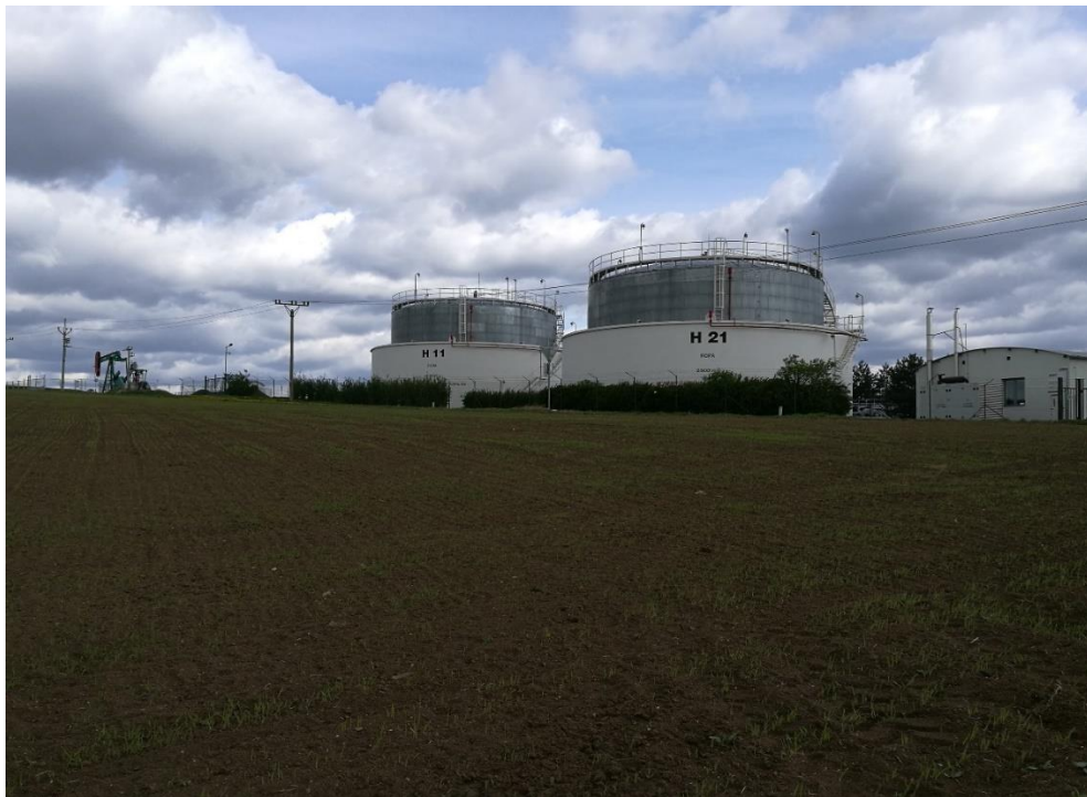
Obrázek 13: Ropné skladovací nádrže v obci Uhřetěves, zdroj: fotografie autorky
