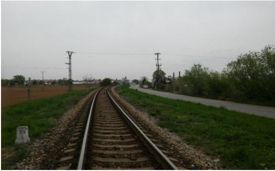
Obr. č. 40 – Rozhled strojvedoucího vlaku ve směru Veselí nad Moravou ve vzdálenosti 700 m (archív autora)
