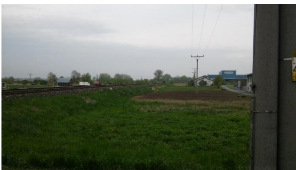
Obr. č. 25 – Rozhled Lp = 575 m ve směru Kvačiče na trať ve směru Ostrožská Nová Ves (archív autora)
