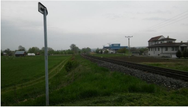
Obr. č. 27 – Rozhled L_p = 590 m ve směru Chylice na trať ve směru Ostrožská Nová Ves (archív autora)
