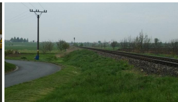
Obr. č. 26 – Rozhled Lp = 703 m ve směru Kvačiče na trať ve směru Uherský Ostroh (archív autora)
