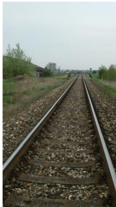
Obr. č. 30 – Rozhled strojvedoucího vlaku ve směru Uherský ostroh ve vzdálenosti 680 m (archív autora)
