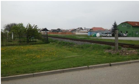
Obr. č. 36 – Rozhled Lp = 70 m ve směru Radějov na trať ve směru Veselí nad Moravou (archív autora)
