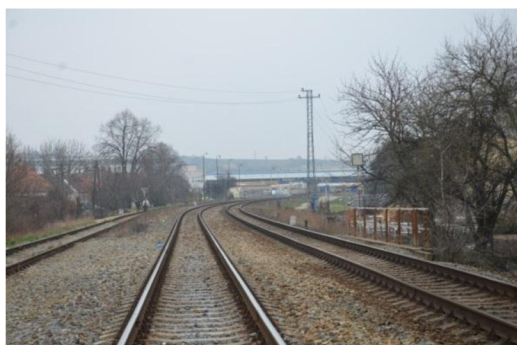
Obr. č. 53 – Rozhled strojvedoucího vlaku ve směru Vlkoš ze vzdálenosti 500 m (archív autora)
