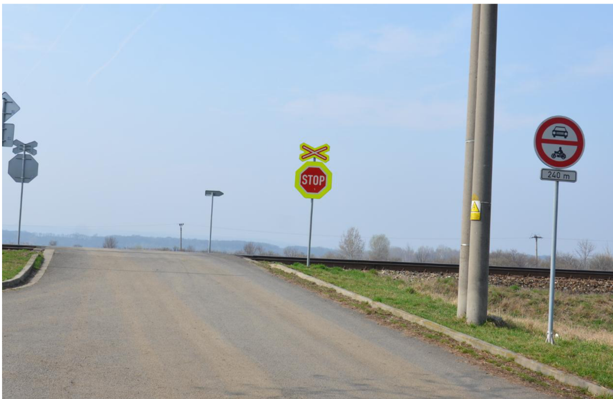
Obr. č. 20 – Pohled na železniční přejezd a dopravní značku B 11 ve směru Kvačice (archív autora)
