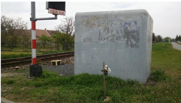
Obr. č. 38 – Rozhled Lp = 8 m ve směru ulice Za Valy na trať ve směru Veselí nad Moravou (archív autora)
