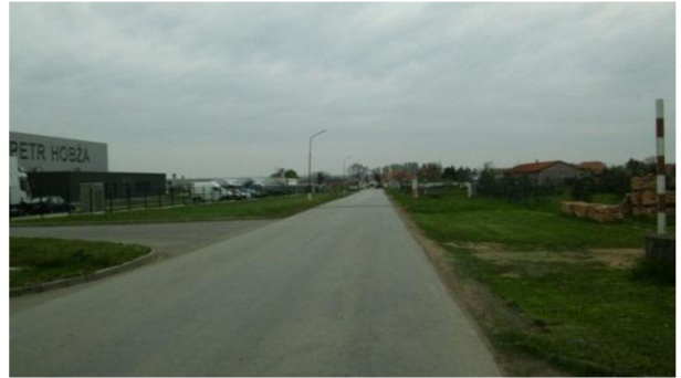
Obr. č. 35 – Pohled na ulici Za Drahou ve směru ulice Za Valy Dz = 300 m (archív autora)
