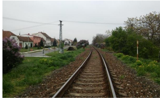
Obr. č. 41 – Rozhled strojvedoucího vlaku ve směru Petrov ve vzdálenosti 530 m (archív autora)
