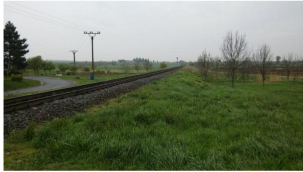
Obr. č. 28 – Rozhled L_p = 653 m ve směru Chylice na trať ve směru Uherský Ostroh (archív autora)
