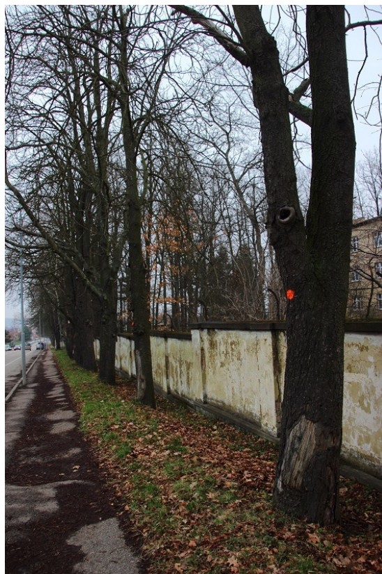
Obr. 7 - Lidická ulice, strom č. 10
