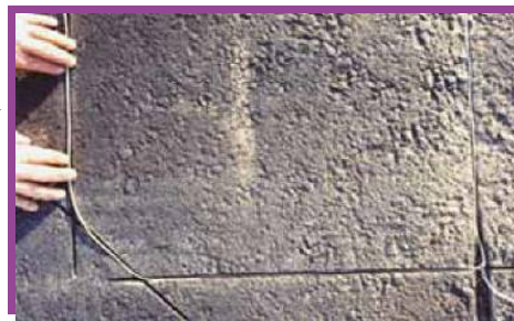
Obr.č. 8: Indukční smyčka - vozovka [20]
