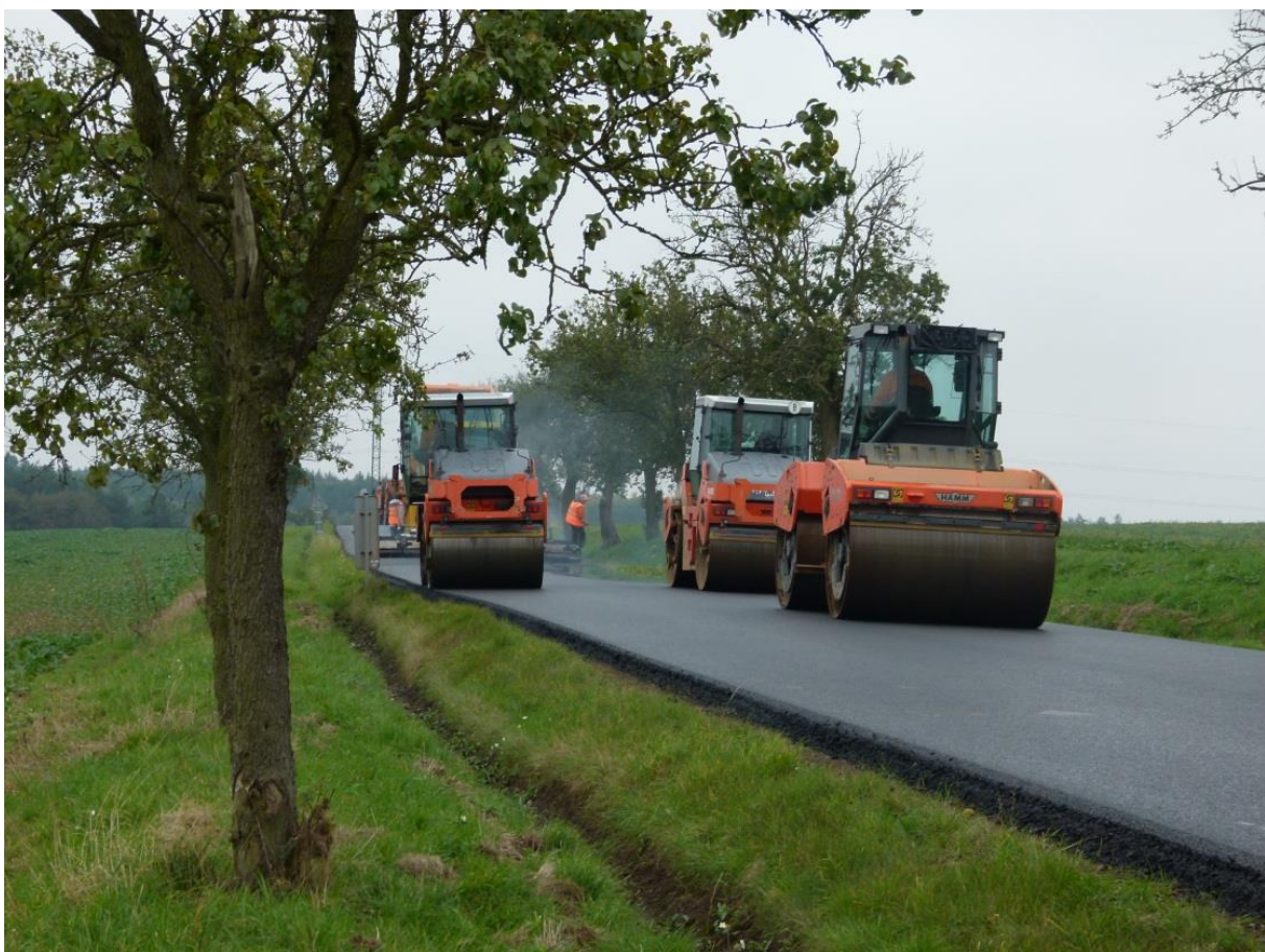
Obrázek 47: Hutnění obrusné vrstvy ze směsi SMA 11S pomocí hutních válců
