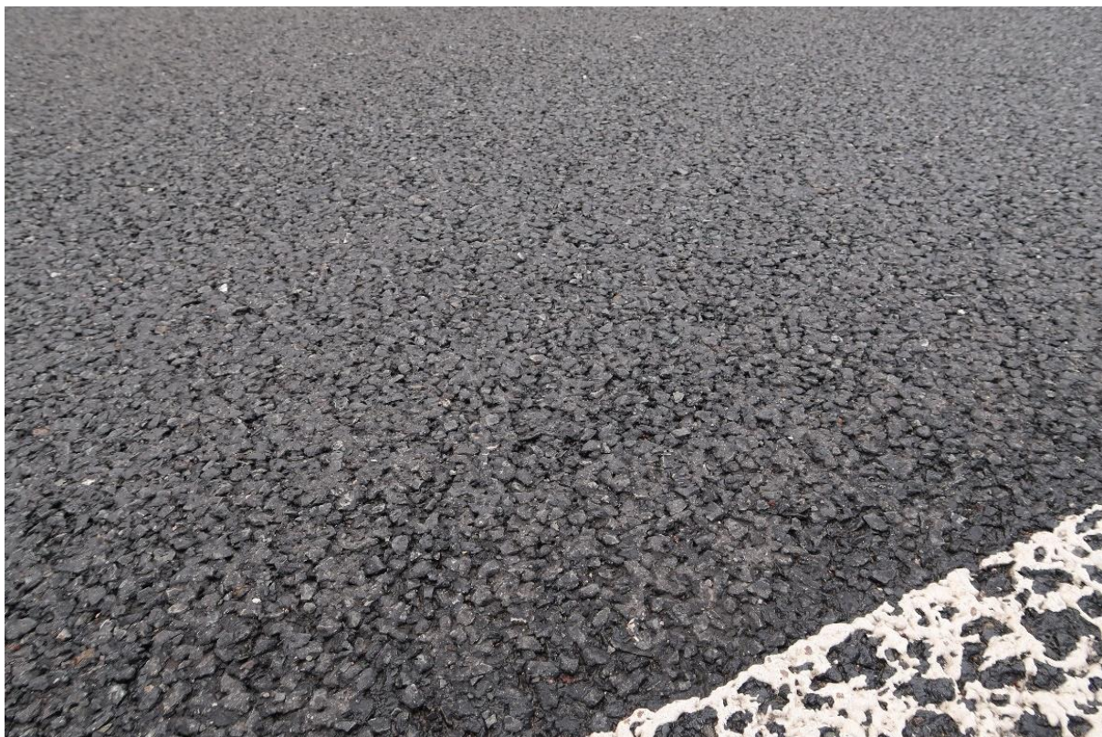
Obrázek 52: Stav varianty směsi 17 v září 2018, lze vidět ojetý asfaltový film z kameniva a tím zajištění dobrých protismykových vlastností povrchu vozovky
