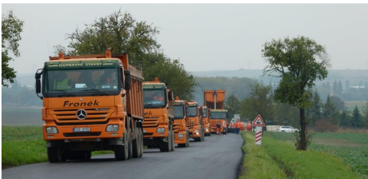
Obrázek 45: Dovoz asfaltových směsí na zkušební úsek II/227
