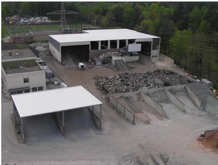
Obrázek 2 Zastřešení skládky předrceného R-materiálu
