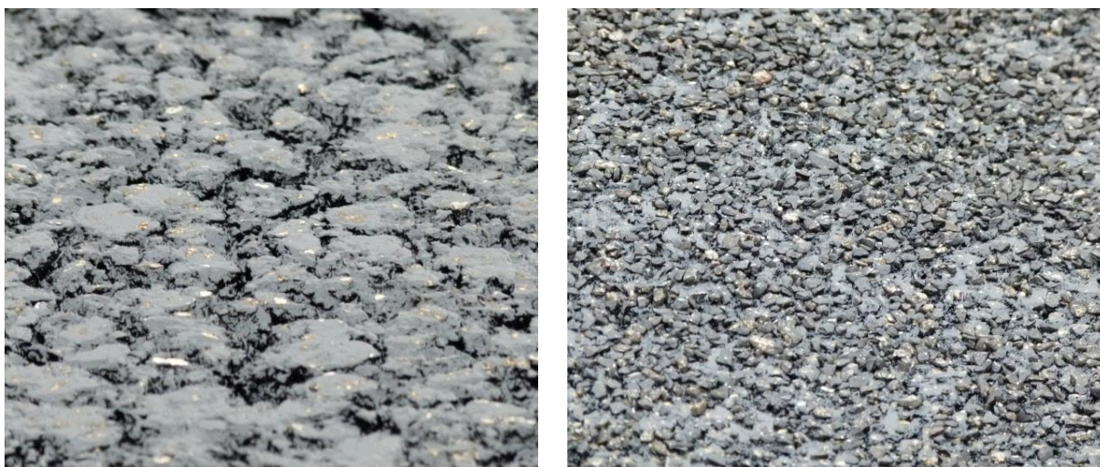
Obrázek 49: Povrch vozovky před podrcením a po posypu jemnou frakcí pro zaválcování
