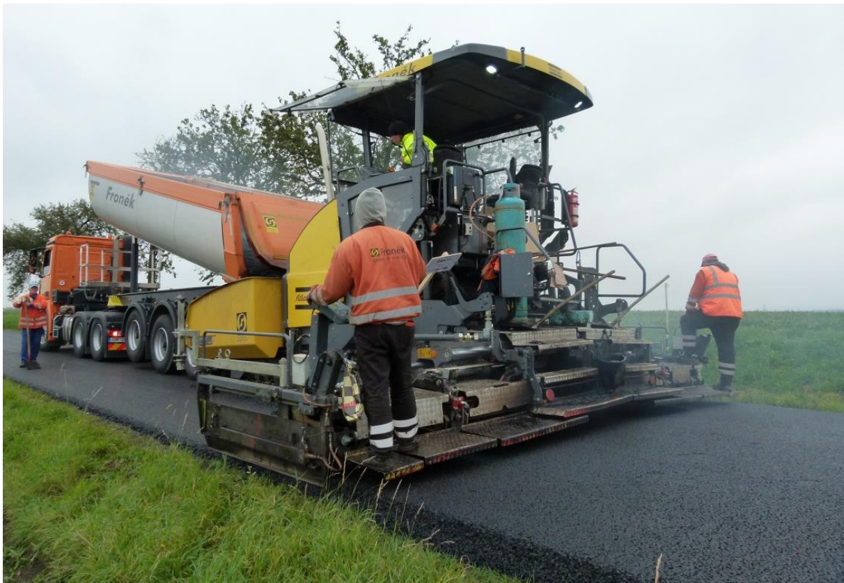
Obrázek 46: Pokládka obrusné vrstvy pomocí finišeru
