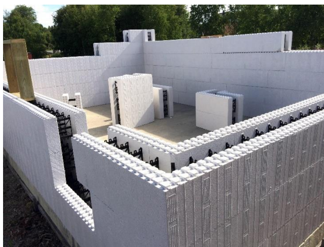
Obrázek 38: ICF systém ve výstavbě [86]
