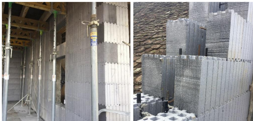
Obrázek 41: Výstavba domu pomocí ICF systému z Grey EPS 200
