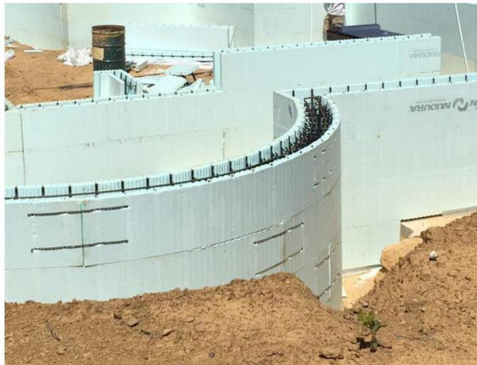
Obrázek 39: Kruhový půdorys vystavěný ze zakřivených ICF bloků [88]
