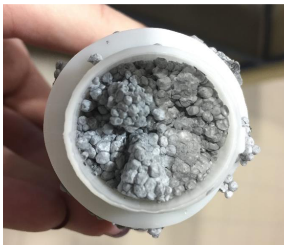
Obrázek 59: Plastová hmoždina po vytrhnutí z tepelného izolantu
