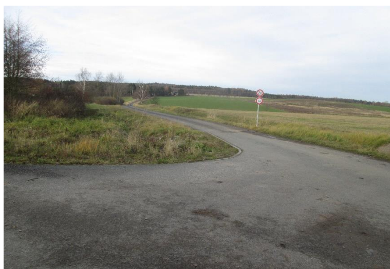
Obec Cerkov. Pohled na zrekonstruovanou místní komunikaci. Foto: H. Nováková
