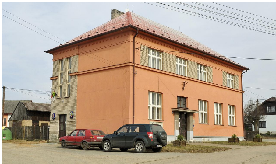
Zrekonstruovaný obecní úřad v obci Líšná, foto R.Kovanda
