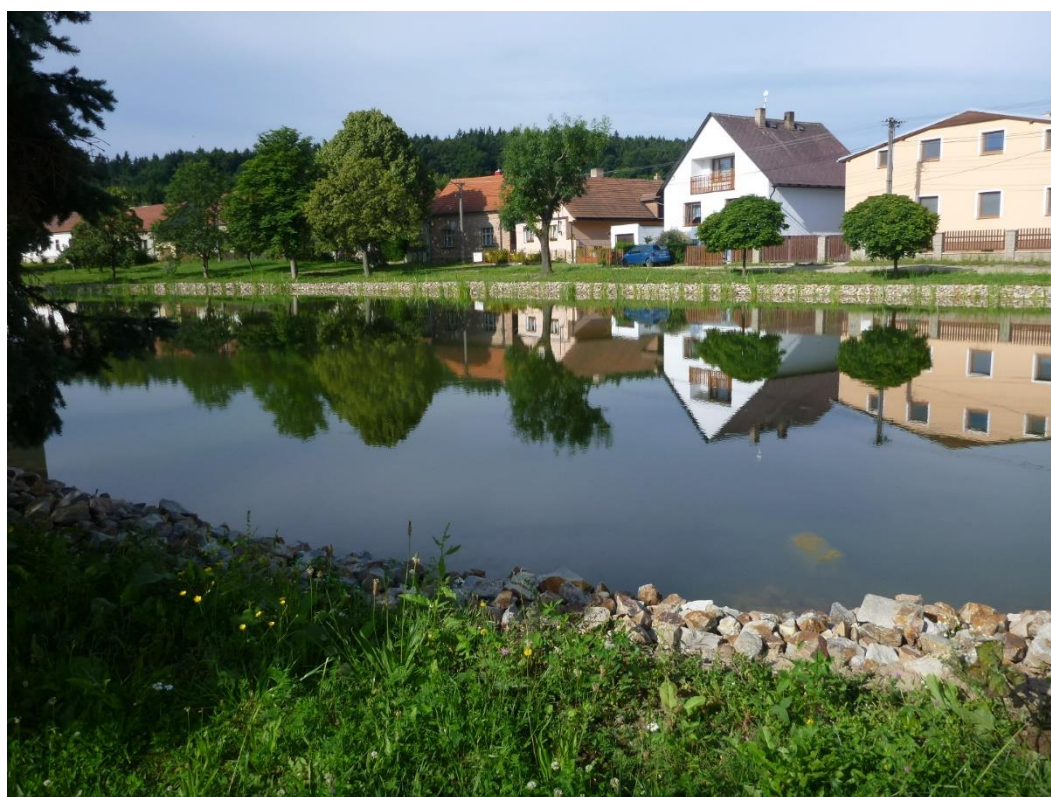
Rekonstrukce vodní nádrže v Sirá, foto: Hana Nováková
