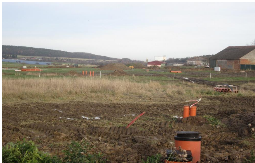
Pohled na budování přípojek pro nové stavební parcely, foto: Hana Nováková
