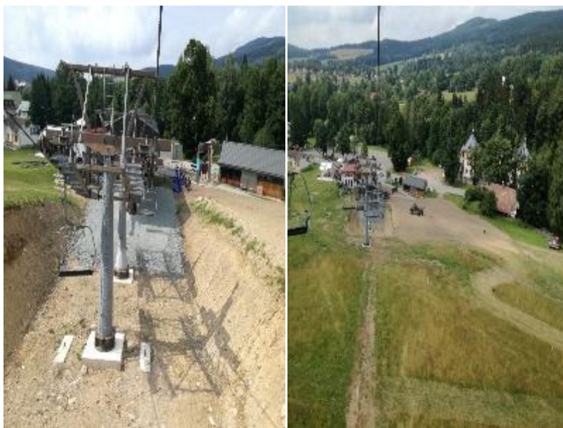
Obrázek 9: Výstavba nové lanovky a terénní úpravy na sjezdové trati MARTA II v Deštném v O. h.
