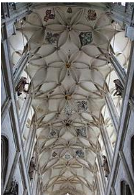
Obrázek 7 - Kroužená klenba hlavní lodi, 2017
