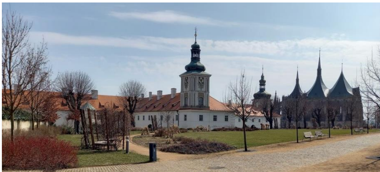
Pohled na jezuitskou kolej z parku, 2021
