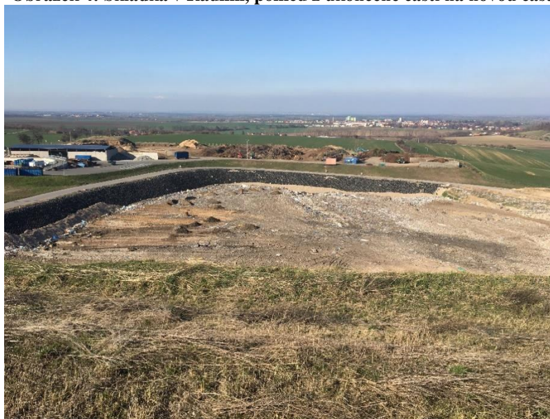
Obrázek 4: Skládka v Radimi, pohled z ukončené části na novou část
