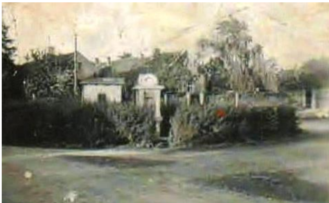
Obrázek 10 - Meteorologická stanice - historická fotografie (Zdroj: Kronika obce)
