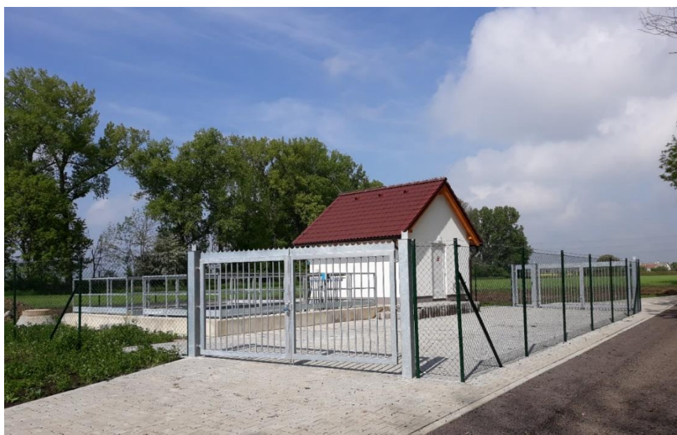
Obrázek 34 - Čistírna odpadních vod (Foto: K. Koberová)
